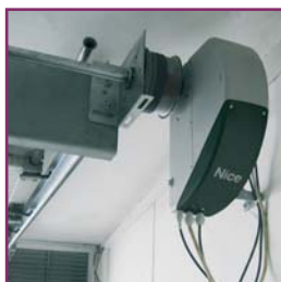
Pohon Sumo může být připevněn přímo na hřídel sekčních vrat
